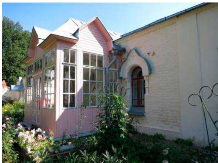
Западный фасад, вид с юго-запада.
