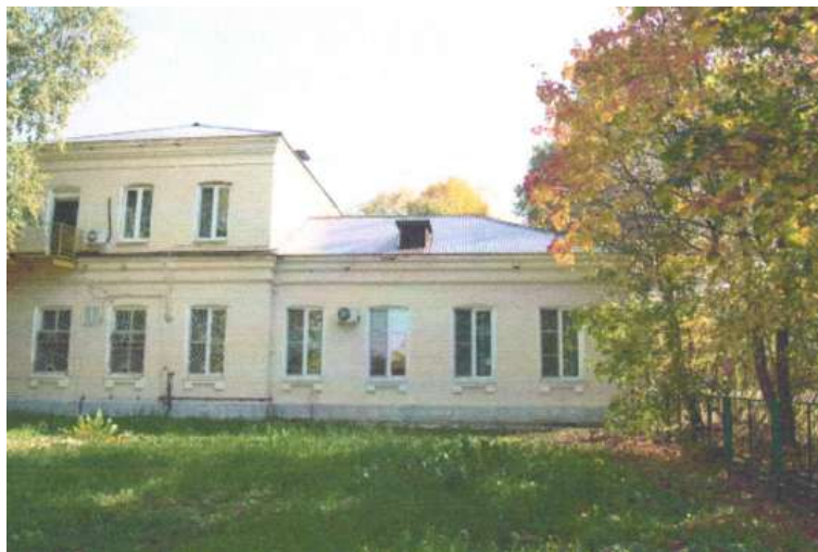
Детский сад. Фрагмент западного фасада.
