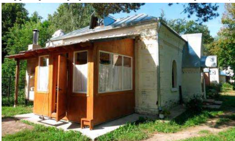
Общий вид с северо-запада.
