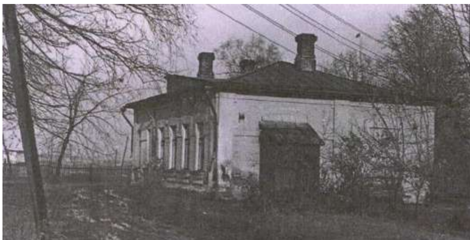
Общий вид здания с юго-запада. Фото 1974 г.
