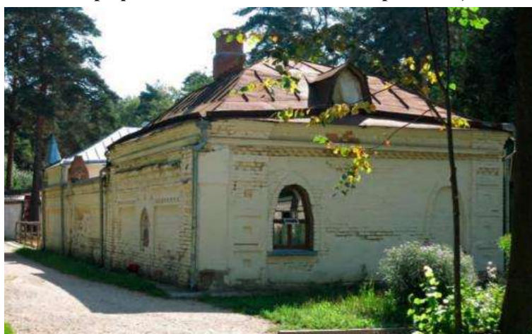
Общий вид с северо-запада.
