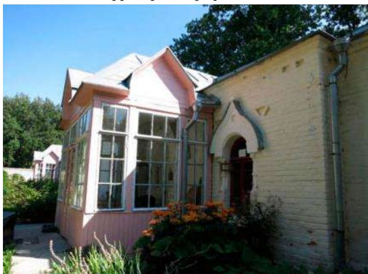
Общий вид с юго-запада.
