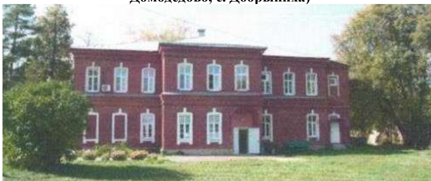
Главный, восточный фасад, северного келейного корпуса.
