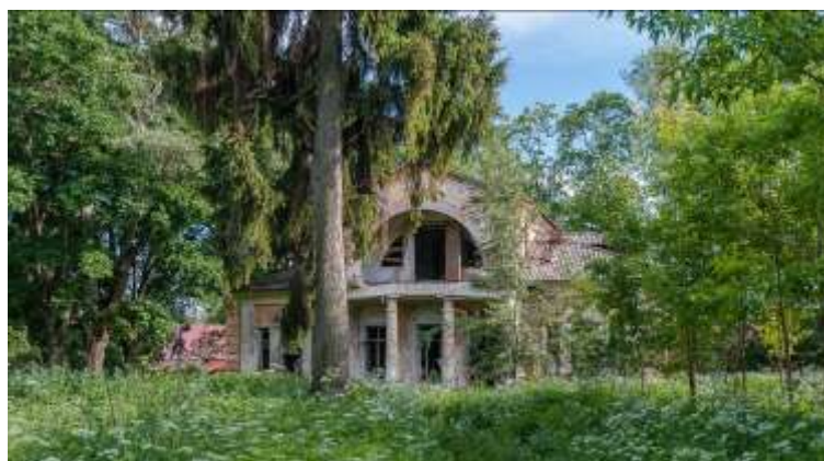
Современный вид ОКН.
