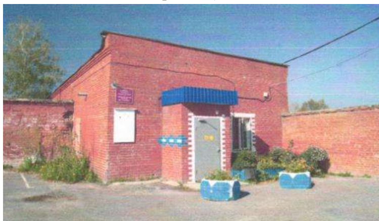
Клуб. Фрагмент юго-восточного фасада.
