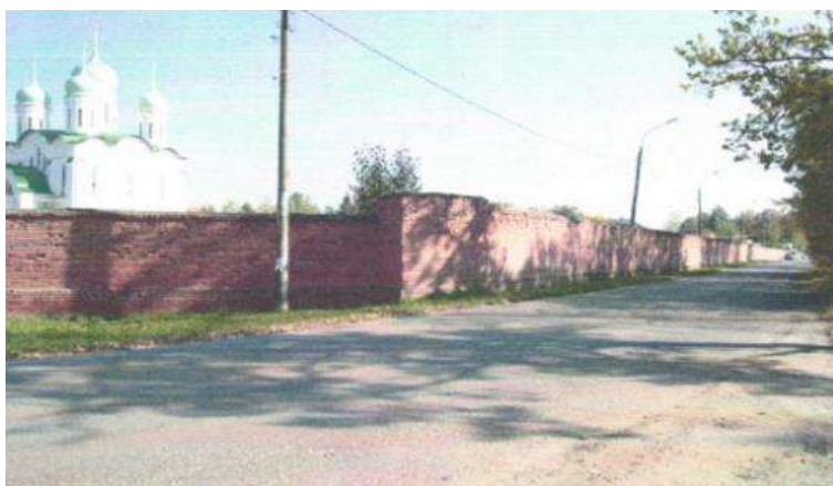
Северо-западная часть ограды.
