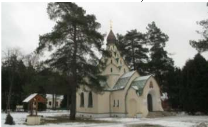
Вид с северо-запада
