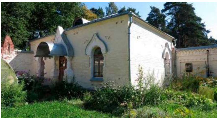
Общий вид с юго-запада.
