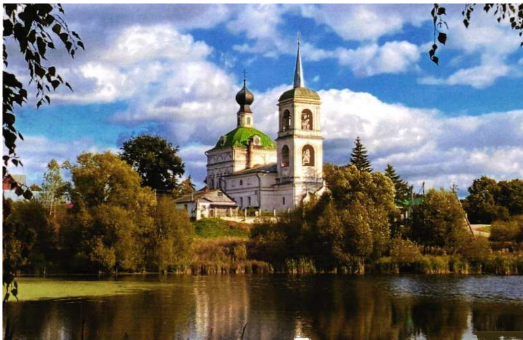
Общий вид с западного берега Малого Шубинского пруда.
