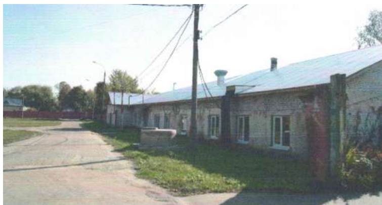
Прачечная. Северо-западный фасад.
