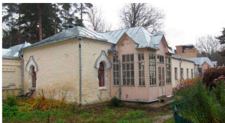
Вид с северо-запада.
